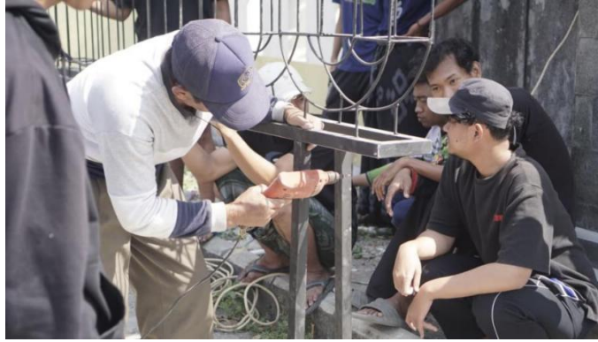
Gambar 7. Pemasangan kerangka landmark
